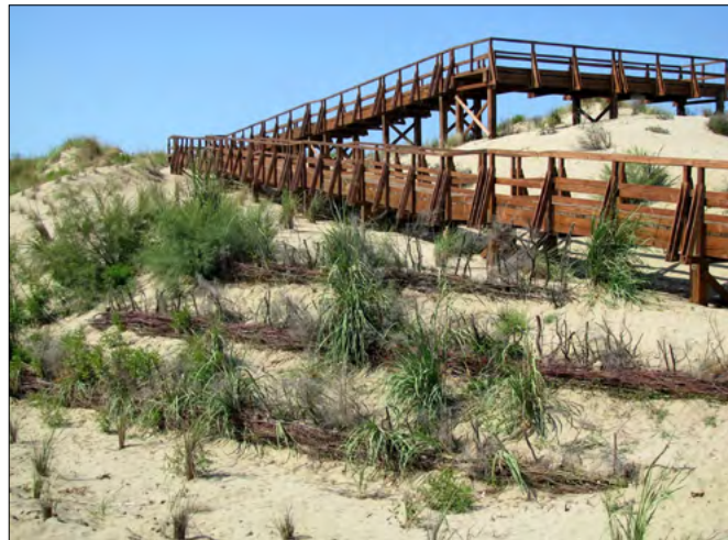
FIGURA 15. Piantumazione di Ammophila arenaria su dune di S. Rossore (da F. Boccalaro, 2008).
