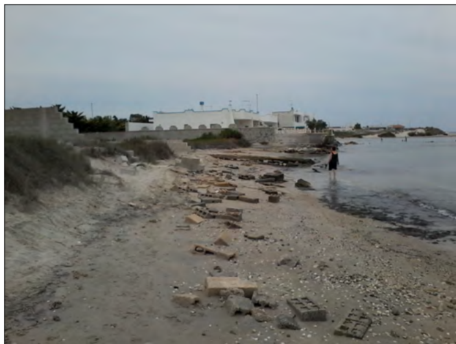
FIGURA 6. Abitazioni ormai in mare soggette a crolli e stato di intenso degrado. Si noti la presenza di un degradato cordone dunale discontinuo e smembrato per la presenza delle abitazioni.
