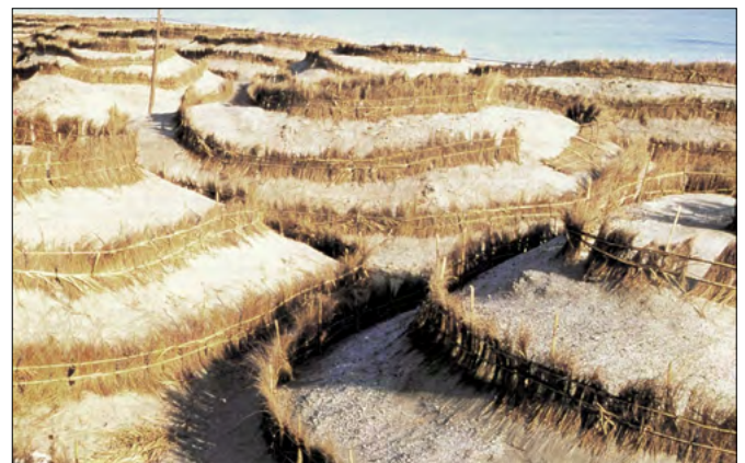
FIGURA 44. Dune recintate dalle fascine a protezione della semina di specie vegetali autoctone (da M.C. Tullio, 2002).
