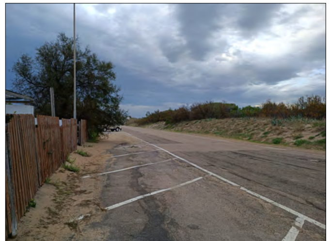
FIGURA 11. L'apertura nella duna della precedente figura favorisce la migrazione delle sabbie nell'entroterra a formare accumuli e vere e proprie dune al di là della strada litoranea.
