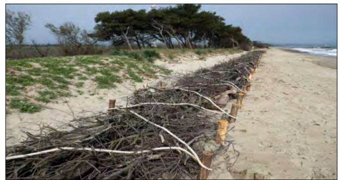
FIGURA 9. Difesa con cataste di legname fissate con corde appena realizzata.
