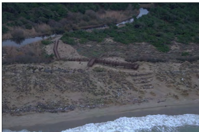
FOTO 4. San Rossore, foce fiume morto vecchio, 2008 - La passerella e la duna ricostituita (v.fascine a dx della passerella) - Foto Porchera.
