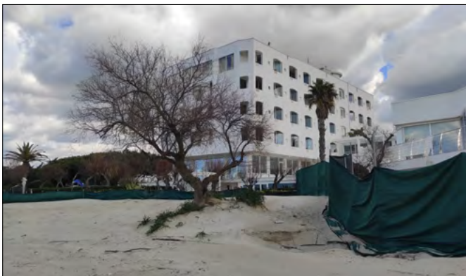
FIGURA 27. Struttura ricettiva posta a ridosso del cordone dune parzialmente smantellato proprio per far posto all'edificio.
