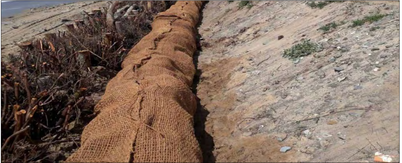
FIGURA 19. Opera di ingegneria naturalistica “biorullo”, costituita da fascinate legate con rete di cocco fissate al terreno con paleria.
