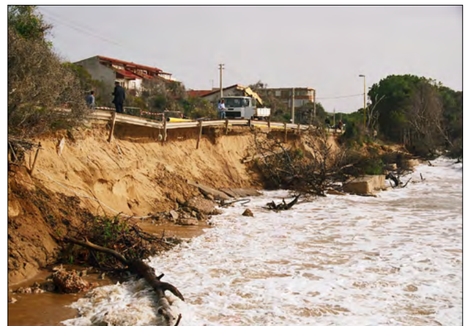
FIGURA 31. Costruire strade asfaltate sulle dune, come quella fotografata a San Leone vicino Agrigento, compromette la funzionalità dell'ecosistema provocandone la frammentazione e alterandone il dinamismo (foto: M. Interlandi).
