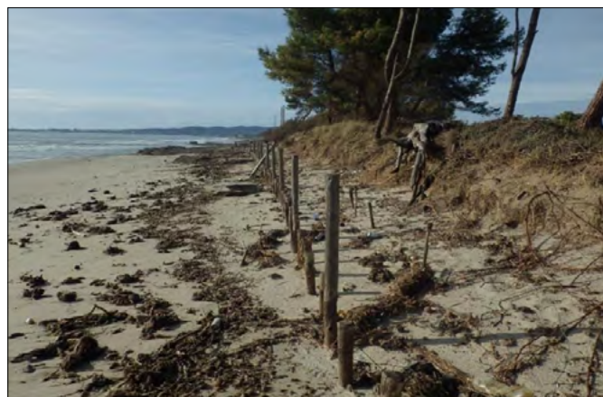
FIGURA 17. Arretramento del piede dunale e dissesto di alcune opere, che sono state in parte svuotate dei materiali costituenti; malgrado l'intensità del fenomeno e dei relativi danni, si è constatato che i dissesti dei tratti di duna protetti sono risultati di minore entità rispetto a quelli privi di opere di difesa.
