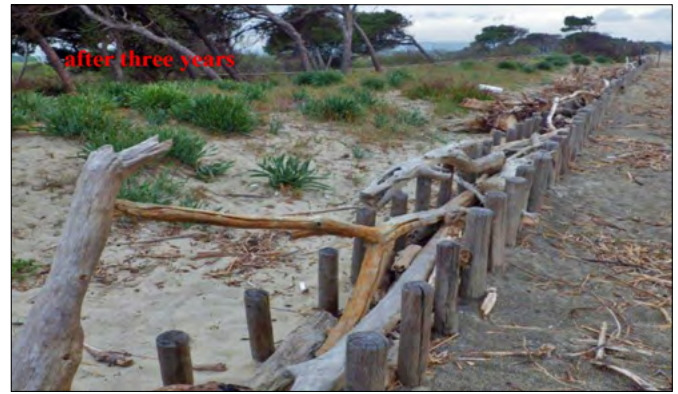
FIGURA 8. Difesa attiva dalle mareggiate che consente la collocazione del materiale legnoso spiaggiato.
