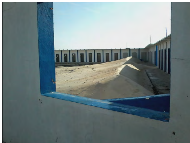
FIGURA 9. Accumuli di sabbia in corrispondenza delle strutture rigide di un lido in muratura
