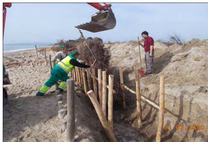
FIGURA 18. Fase di recupero e consolidamento delle opere interessate dai danneggiamenti dell'evento critico.
