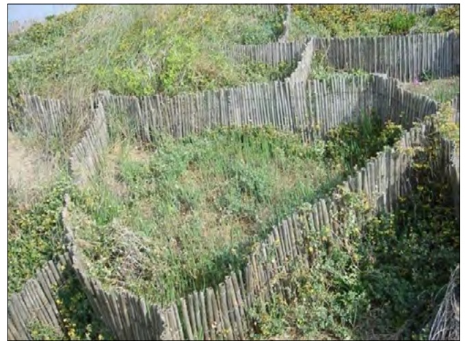
FIGURA 48. Realizzazione di schermatura romboidale a Sabaudia (da F. Boccalaro, 2002).
