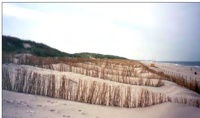
FIGURA 50. Schermatura con ramaglia a Texel, NL (da DEFRA, 1999).
