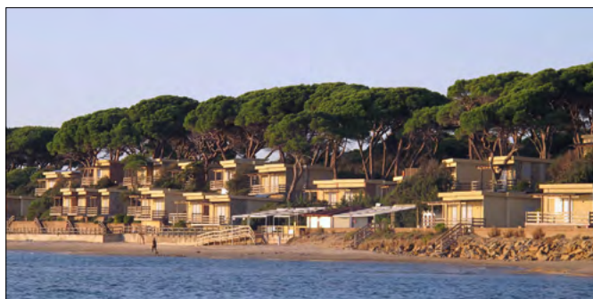
FIGURA 16. Villaggio turistico costruito sulla duna del Golfo di Follonica. L'erosione della spiaggia aveva causato gravi problemi di stabilità agli edifici ed ha imposto la costruzione di opere di difesa del litorale che hanno accentuato l'erosione nei settori di costa adiacenti.
