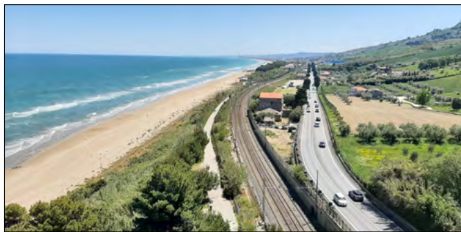
FIGURA 1. La costruzione delle ferrovie litoranee è stata una delle principali cause della distruzione degli ecosistemi di spiaggia-duna in Italia. Nella foto, un tratto della linea adriatica, in prossimità dell'Area Marina Protetta "Torre del Cerrano". Foto S. Fattorini.
