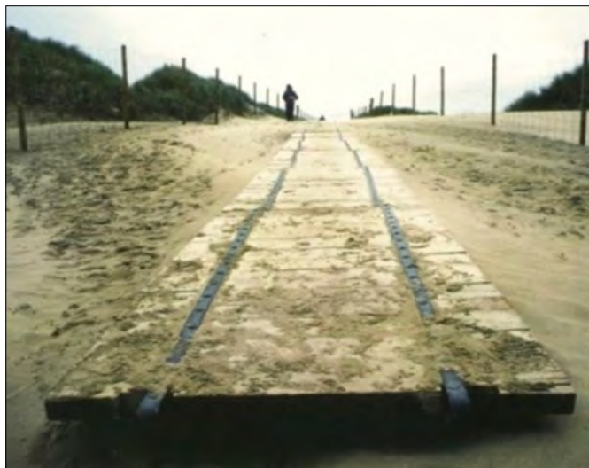
FIGURA 24. Passerella in legno per l'attraversamento di un campo di dune in Galles (da Alan Brooks &amp; Elizabeth Agate, 2004).
