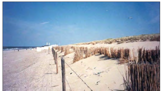
FIGURA 20. Intervento di stabilizzazione di dune costiere con griglie di siepi morte (Texel, Olanda) (da DEFRA, 1993).
