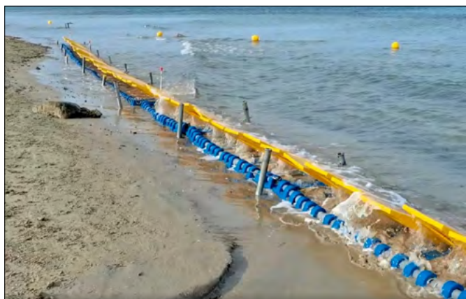
FIGURA 5. La trappola sedimentaria costituita dai moduli del sistema opportunamente posizionati lungo la linea di costa.
