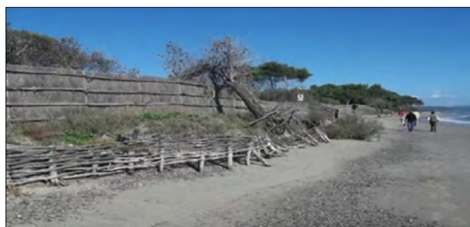
FIGURA 5. Soluzioni di difesa ordinarie, di scarsa efficienza, su dune costiere strette a ridosso della linea di costa.
