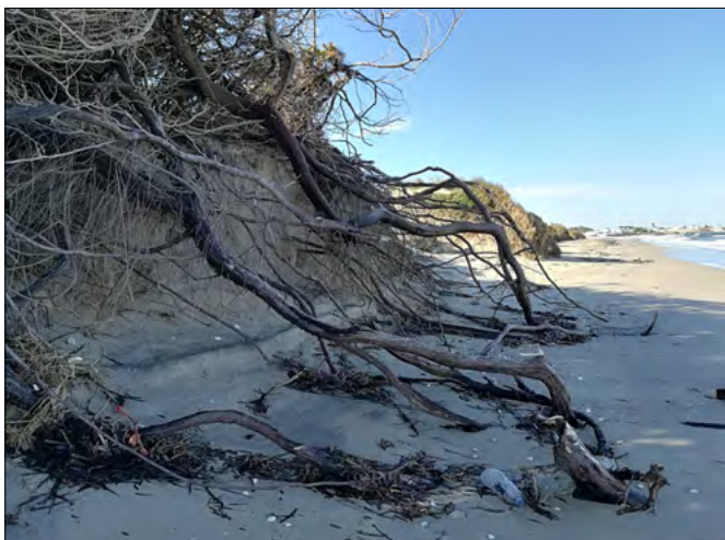
FIGURA 4. Cordone di dune in avanzato stato di erosione a Spiaggiabella.
