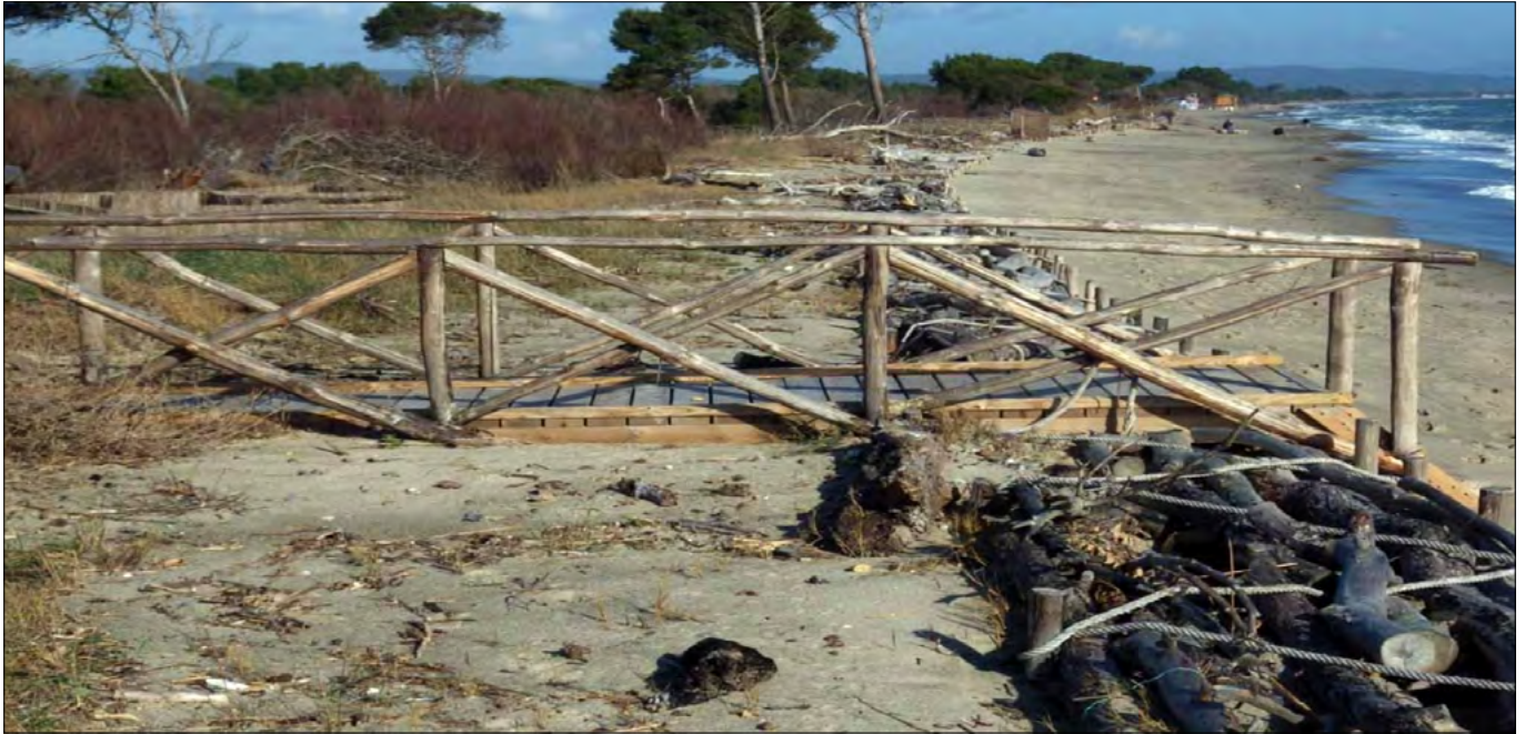
FIGURA 14. Passerelle per il controllo degli accessi integrate con le opere di difesa e protezione.
