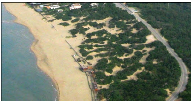
FIGURA 7. Erosione di dune nel Circeo (da F. Boccalaro, 2009).
